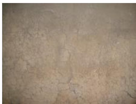
写真 15：大谷石製内壁の粘土養生
