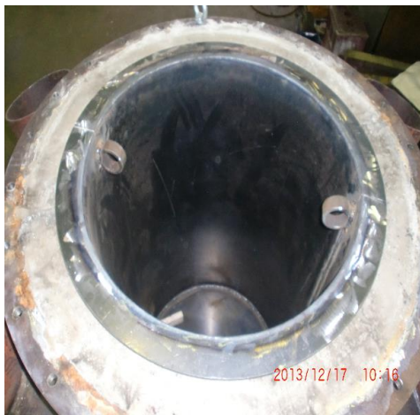
写真 4：製作状況①（酸化層内部還元層取付）
