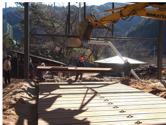
写真 13：窯出しの様子② （鉄蓋を開ける作業）
