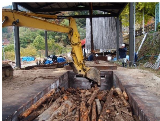
写真 10：重機での立て込み
