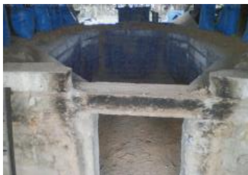
写真 14：窯建設状況（大谷石利用）
