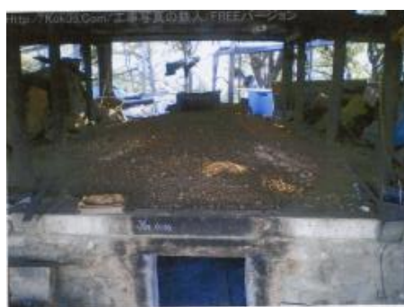
写真 17：上蓋装着後保温用土（粘土質）養生
