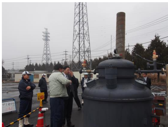
写真 26 : 最終発電試験の様子
