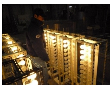
図 18 正英製作所内での試運転における、発電状況の確認状況
